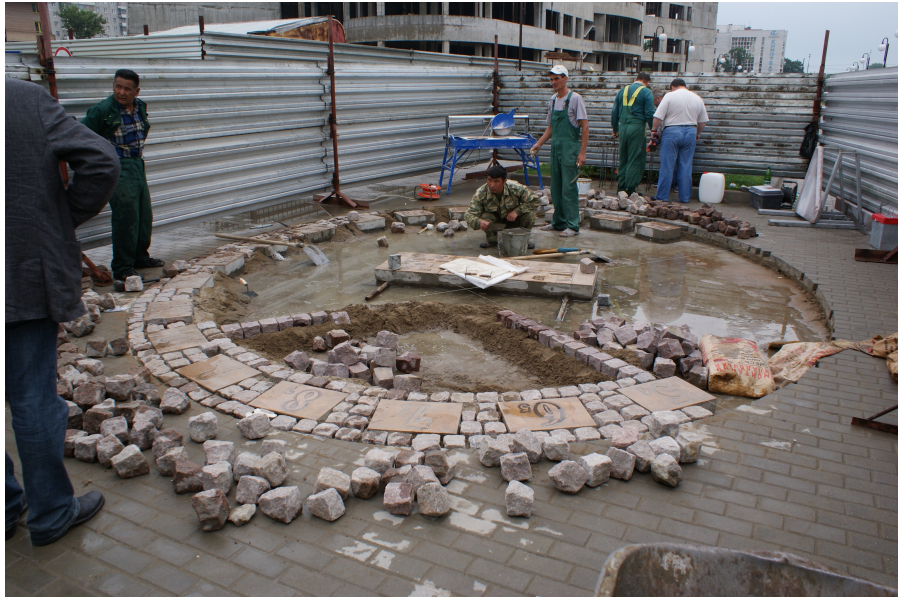
Иллюстрация 7: Монтаж солнечных часов на набережной
